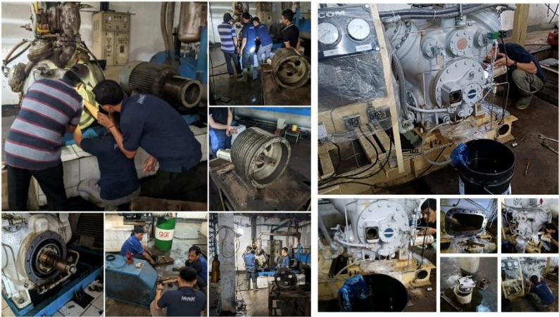
Mei 2025 Perbaikan Compressor sabroe dan mycom 50 ton
